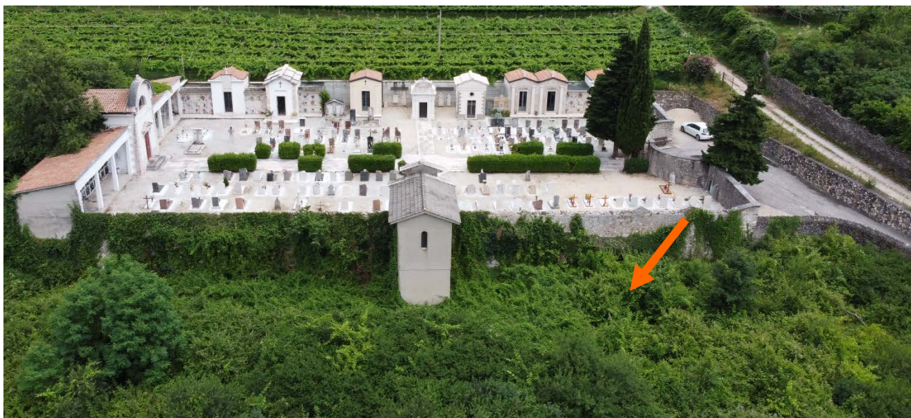
Immagine 5. Vista dei percorsi con evidenziate le criticità di incespicare e di caduta dall'alto.
