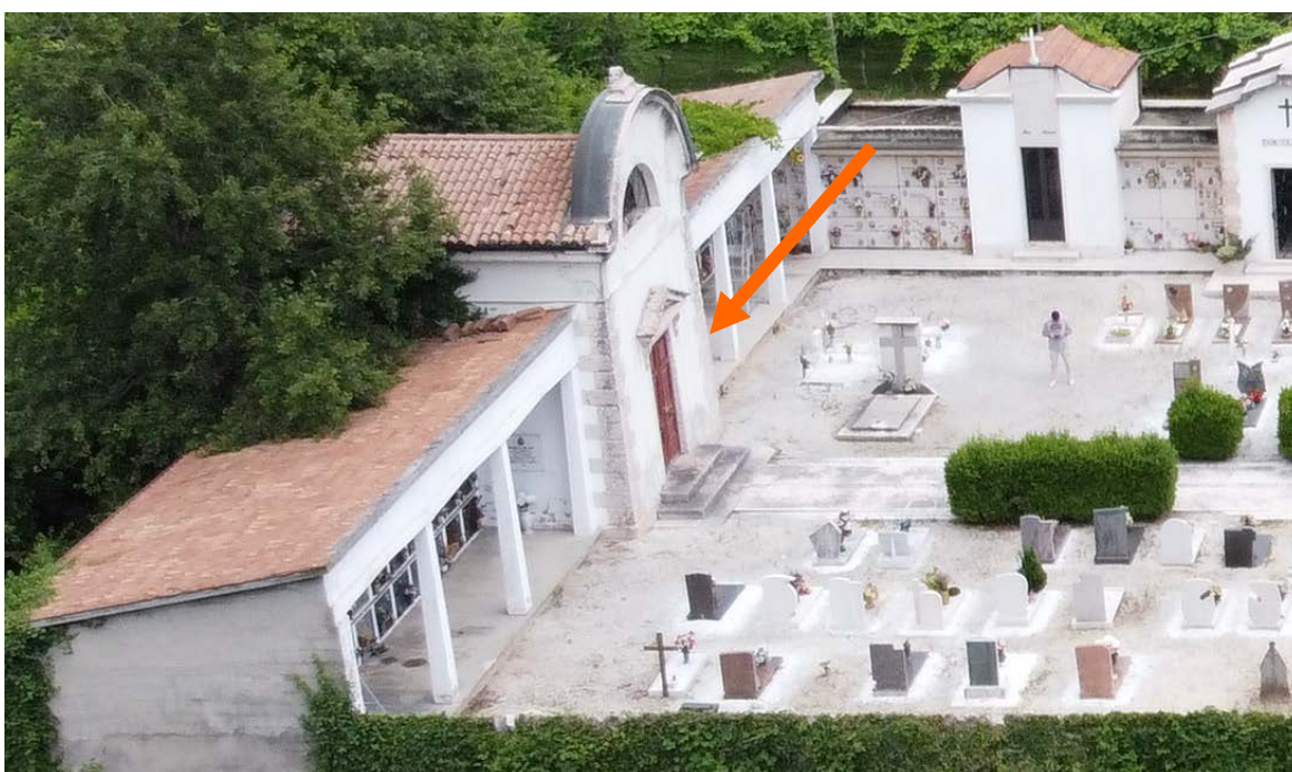
Immagine 2. Immagine da drone con individuato il manufatto oggetto di intervento. (vedi freccia)
