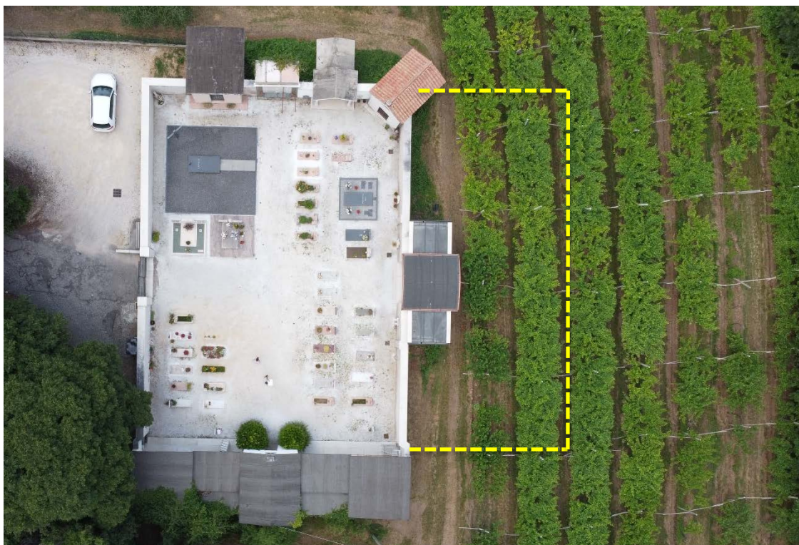
Immagine 4a. Individuazione dell'area interessata dall'intervento (vedi tratteggio).
